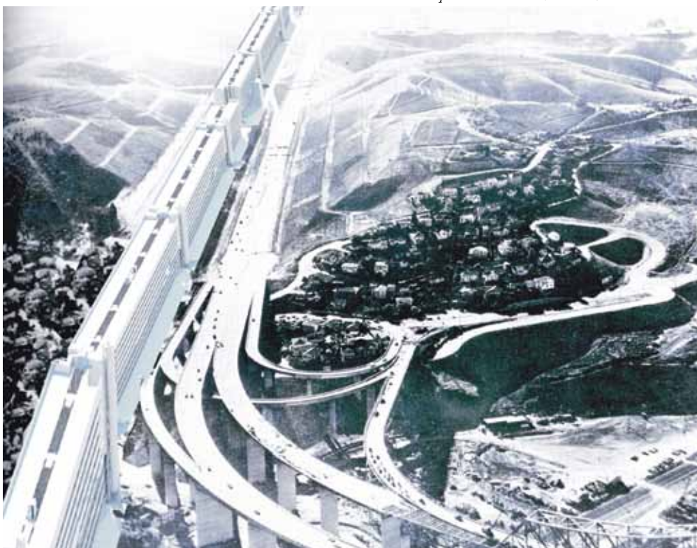
Foto Montaggio: Corviale - Monumento Continuo
