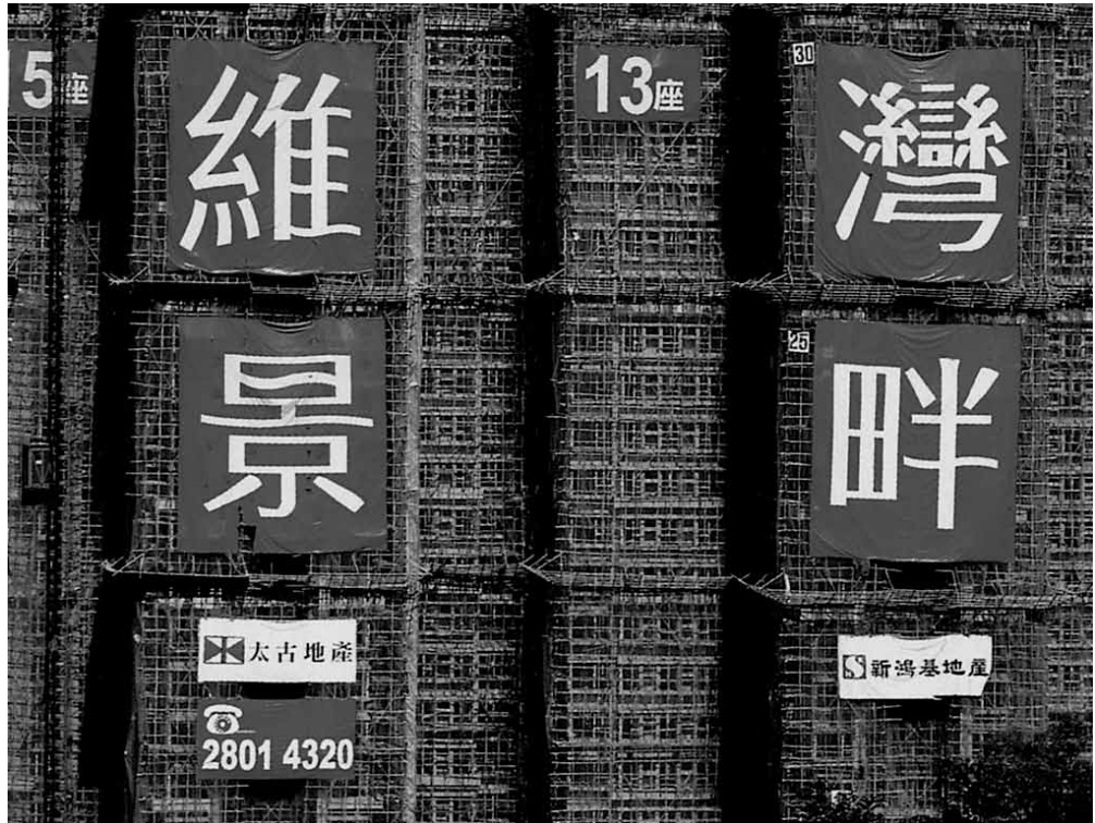
Shenzhen, China: Impalcature di Bamboo / Bamboo scaffold
